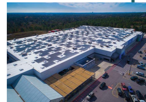
Projetos de montagem no telhado: A EDPR NA DG detém e opera 110 MWp de projetos solares em telhados em todo o país.
