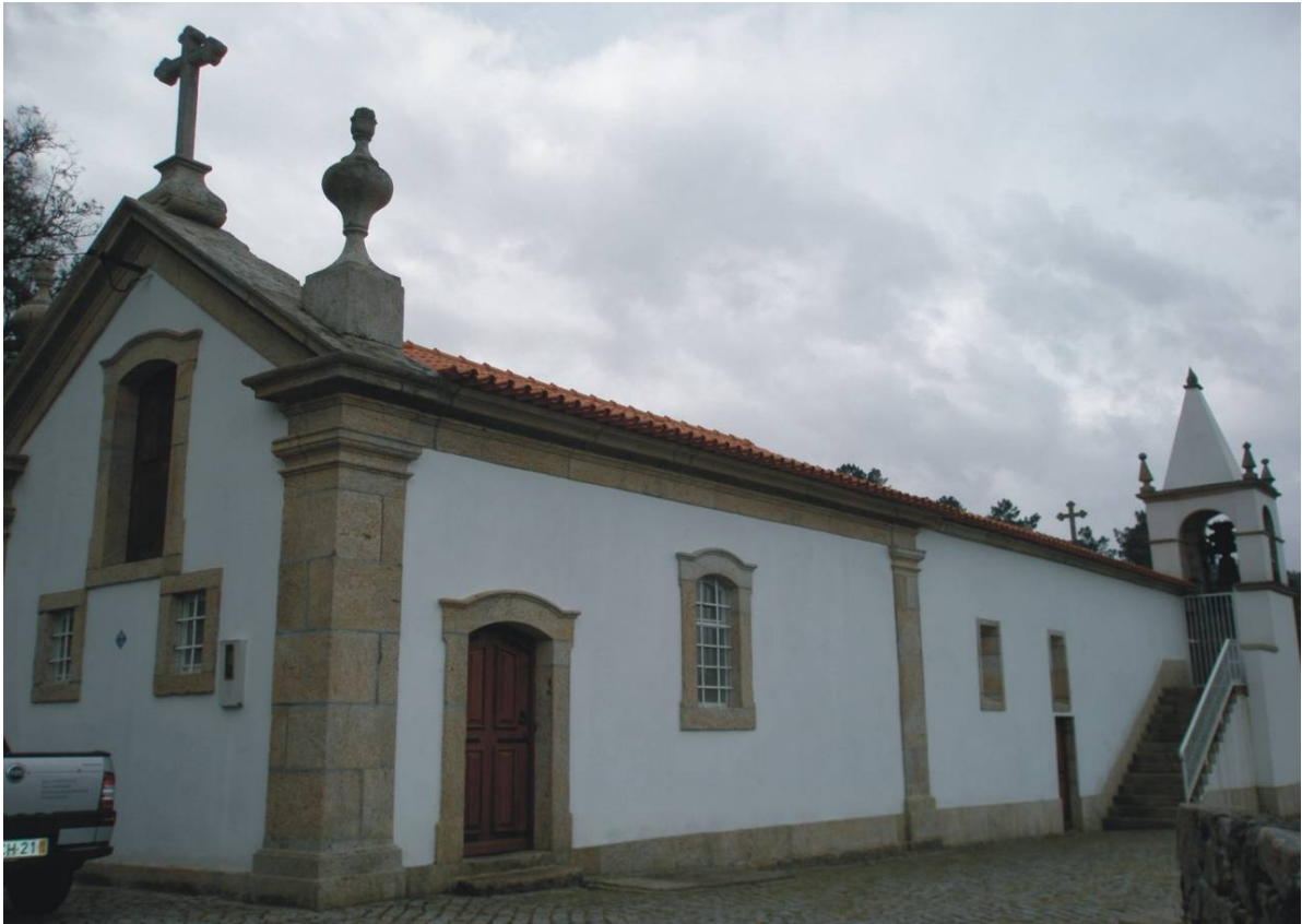
Fotografia 3.1 - Aspecto da Igreja de Sejães
