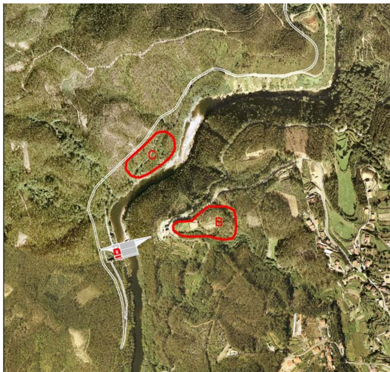
Figura 3.13 – Áreas de Estaleiro (B e C) na Zona da Barragem de Ermida
