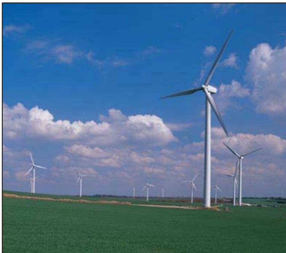
Figura 3 - Aerogerador GEWE 1.5S (1500 kW)
