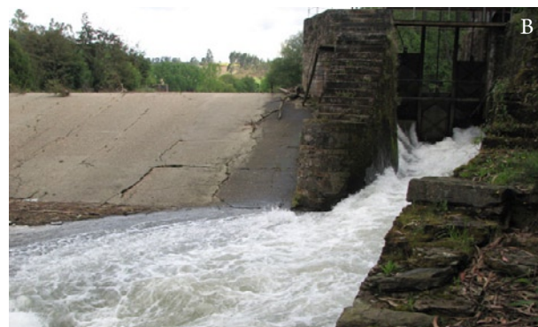
Figura 7 – Obstáculo nº1, Estação de captação da Foz do Sousa, (A) num período de cheia (única ocasião em que se forma uma pequena lâmina de água sobre o açude) e (B) pormenor da passagem lateral da margem esquerda.
