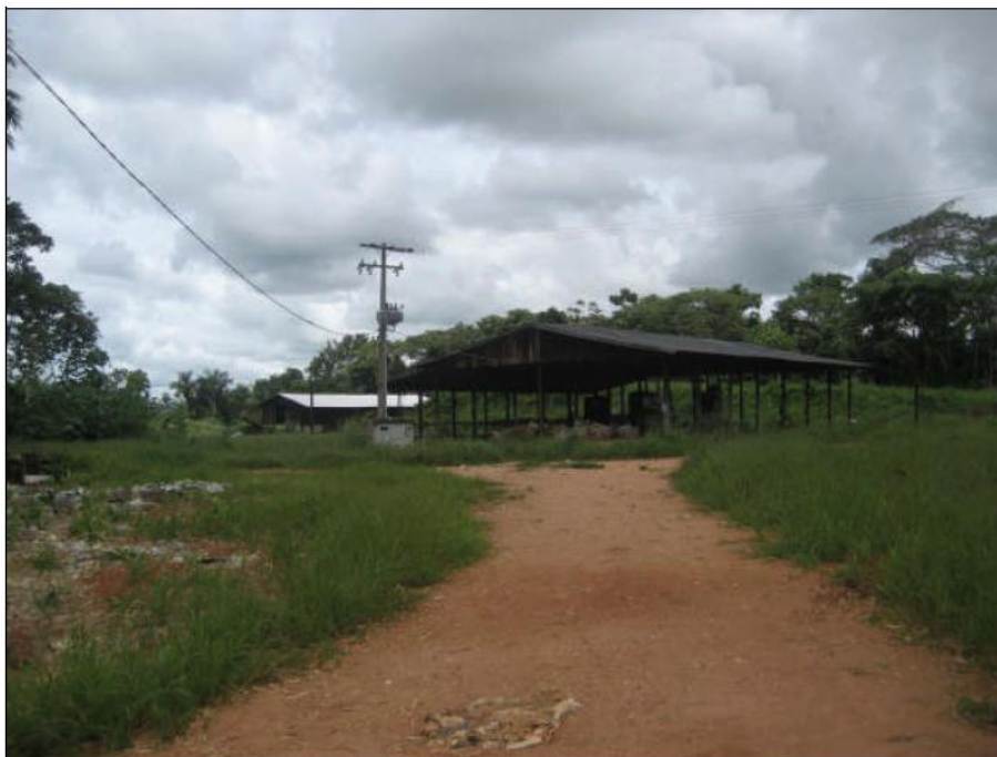
Figura 3.2 - 2 – Aterro Sanitário "Mauro Marino".
