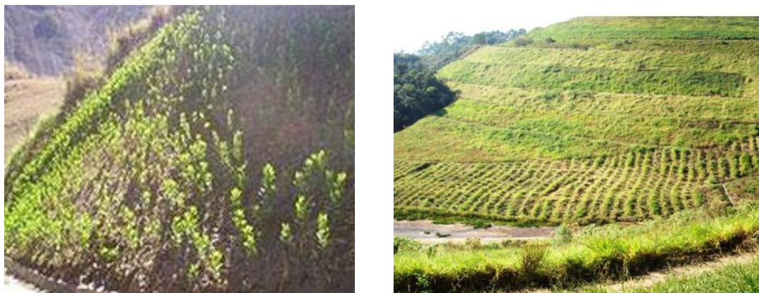
Figura 3.3 - 4 – Recuperação de corte de terreno para via de acesso, com manta e hidrossemeadura de gramíneas e leguminosas.
