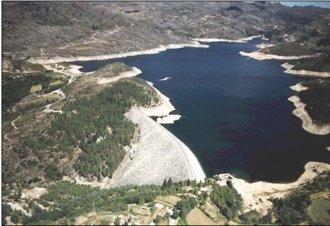
Figura 4.6.1 - Barragem da Paradela (Minho, sendo visível uma variação de 10 m). Este fenómeno será praticamente inexistente em Ribeiradio e terá uma expressão de 5 m em Ermida
