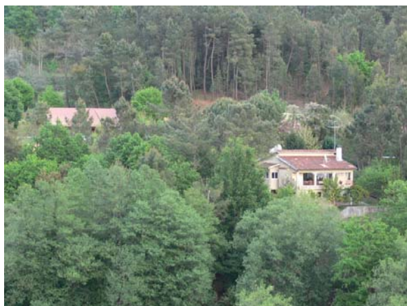
Casa junto à EN-333-3 em Sejães que ficará submersa pela albufeira
