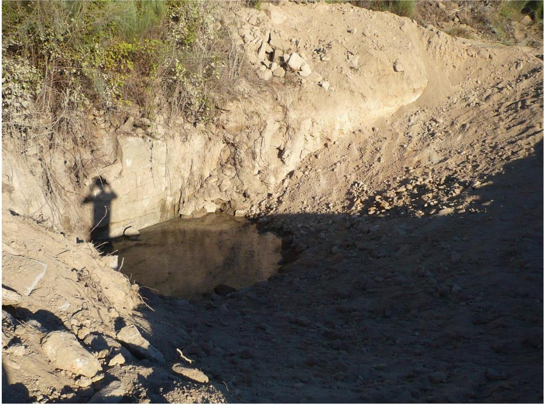
**Figura 51** - Código: FB12 – Local: Casa Grande (Vale de Afonsinho); Situação inicial: poço sem acesso para fauna; Intervenção: transformação de poço em charca; Resultado final: positivo; charca ampla com rampa larga e suave; Situação actual: seca devido a falta de precipitação.
