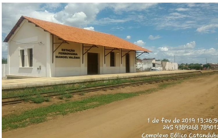
Foto 136 – Antiga estação ferroviária de Pedro Avelino/RN, após restauração. Fonte: Case Soluções Ambientais – CSA, fevereiro de 2019.
