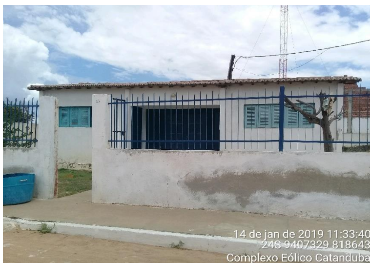
Foto 119 – Escritório da CAERN em Pedro Avelino/RN, All do empreendimento. Fonte: Case Soluções Ambientais – CSA, fevereiro de 2019.
