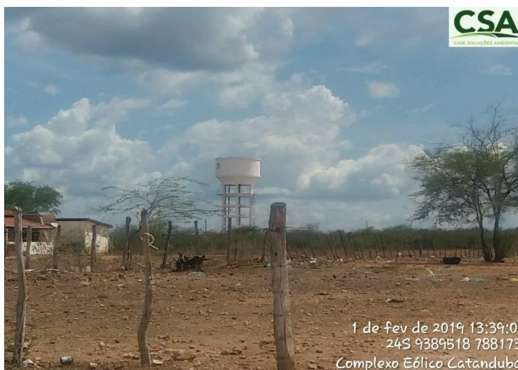
Foto 125 – Caixa de água da CAERN, para o abastecimento da população de Pedro Avelino/RN, All do empreendimento. Fonte: Case Soluções Ambientais – CSA, fevereiro de 2019.
