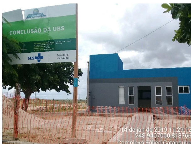
Foto 94 – UBS em construção no município de Jandaíra/RN, All do empreendimento. Fonte: Case Soluções Ambientais – CSA, janeiro de 2019.
