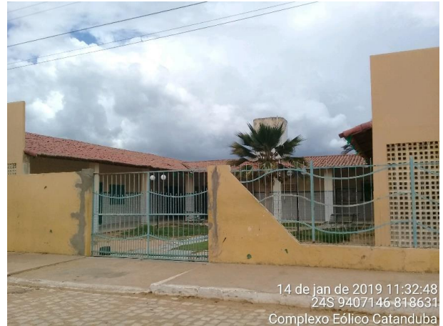
Foto 100 – Escola Estadual no centro do município de Jandaíra/RN, All do empreendimento Fonte: CSA, janeiro de 2019.
