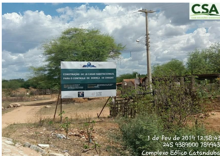
Foto 118 – Construção de casas de alvenaria no bairro São Francisco, em Pedro Avelino/RN, como parte do projeto de erradicação das casas de taipa existentes no local. Fonte: Case Soluções Ambientais – CSA, fevereiro de 2019.
