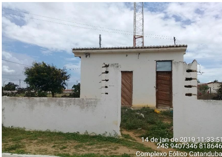
Foto 141 – Torre de TV e celular no centro do município de Jandaíra/RN, AII do empreendimento. Fonte: Case Soluções Ambientais – CSA, janeiro de 2019.
