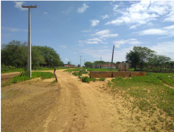
Foto 32 – Ponto 1. Fonte: CSA, fevereiro de 2019.
