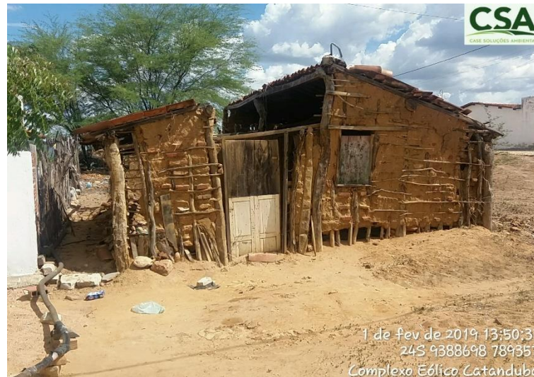
Foto 117 – Casa de taipa abandonada, localizada no centro de Pedro Avelino/RN. Fonte: Case Soluções Ambientais – CSA, fevereiro de 2019.
