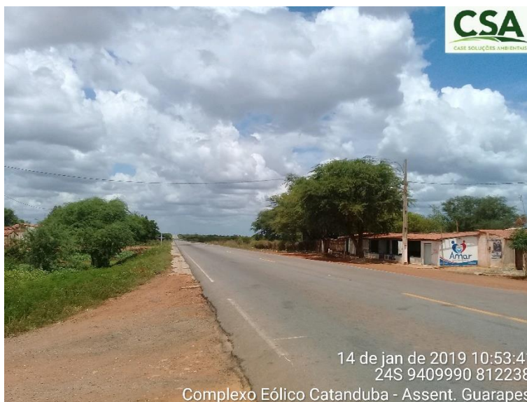
Foto 137 – Rodovia BR 406 nas imediações do Assentamento Guarapes, AID do empreendimento. Fonte: Case Soluções Ambientais – CSA, janeiro de 2019.
