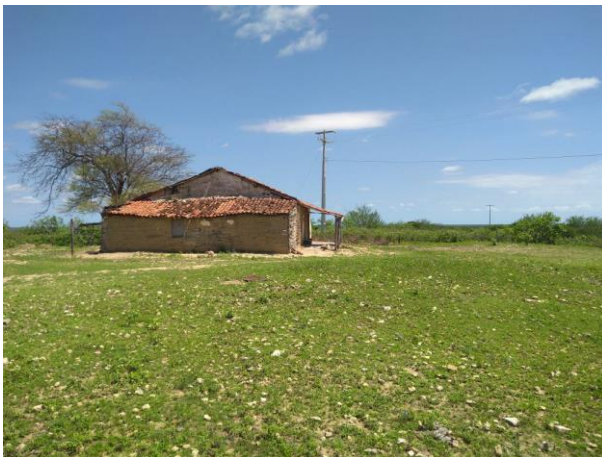
Foto 34 – Ponto 3. Fonte: CSA, fevereiro de 2019.
