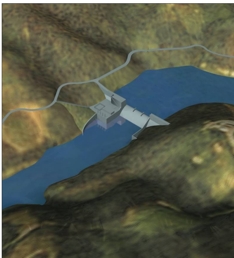
Figura 7 - Vista do Escalão de Ermida
