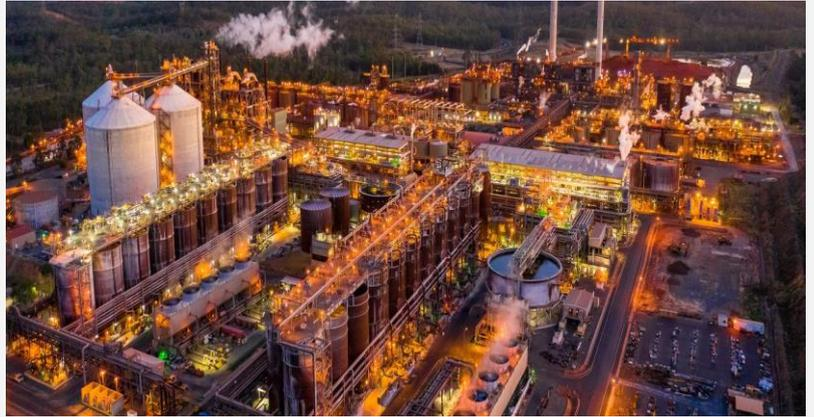
A produção de alumina, o principal ingrediente do alumínio, requer grandes quantidades de energia. No processo, a etapa final é a calcinação, que aquece o hidrato de alumina da etapa de precipitação anterior a temperaturas superiores a 1.000°C para formar alumina anidra. Atualmente, a calcinação é um processo de uso intensivo de energia, para o qual, atualmente, o combustível predominante é o gás natural.
