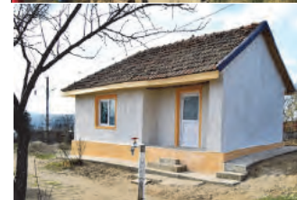
Antes y después de las obras
