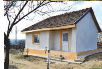
Antes y después de las obras
