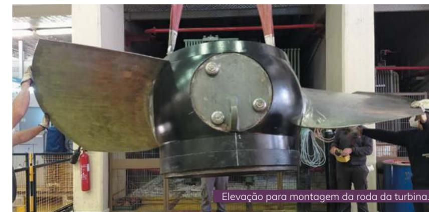
Elevação para montagem da roda da turbina.
