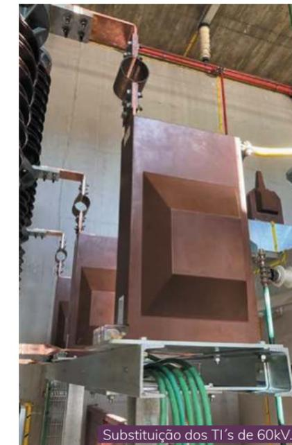
Substituição dos TI's de 60kV.
