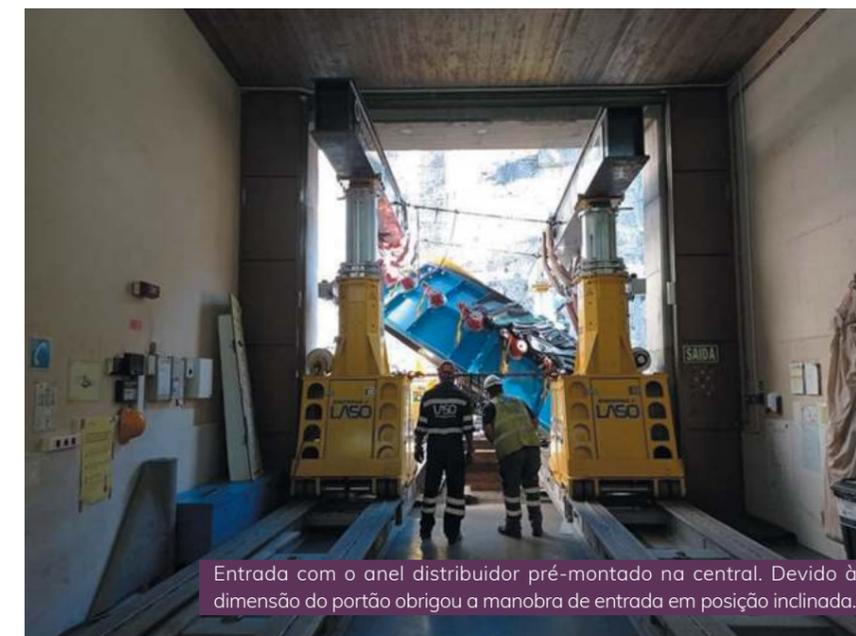
Entrada com o anel distribuidor pré-montado na central. Devido à dimensão do portão obrigou a manobra de entrada em posição inclinada.
