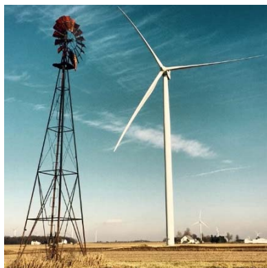
Antiguos y nuevos aerogeneradores en Headwaters
