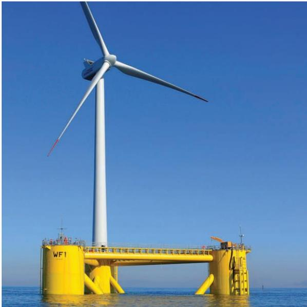
O projeto 'WindFloat' é uma das bandeiras dos projetos de I&D em energias renováveis na EDP, com um protótipo offshore de águas profundas que vem apresentando excelentes resultados após três anos de funcionamento em condições adversas, tendo de suportar ondas de até 15 metros de altura, ao largo da costa da Aguçadoura, no norte de Portugal.
