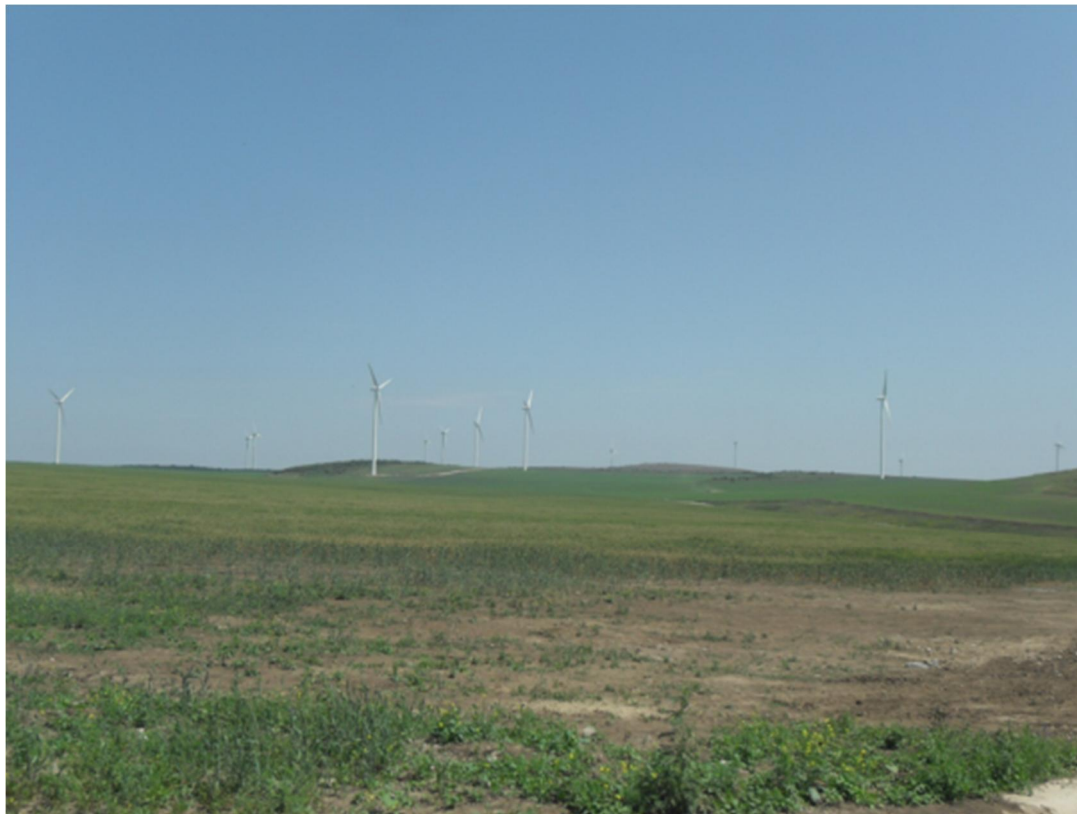
Plansa 2 – Imagine tipica a amplasamentului Sarichioi de la statia de transformatoare (Sursa: fotografie luata in timpul vizitei amplasamentului din luna mai 2012)
