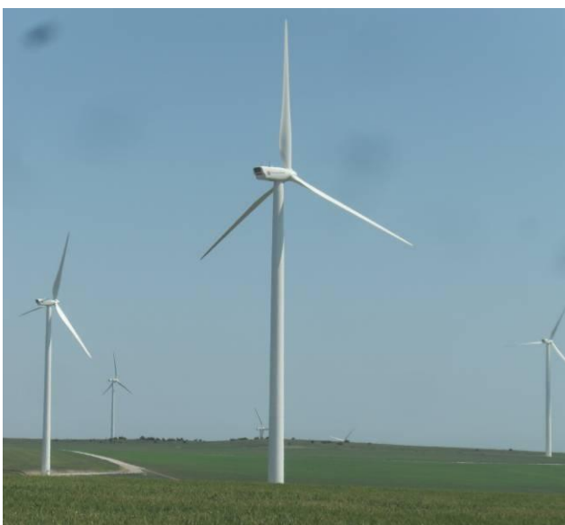
Figura 8 – Vedere generală a sitului
