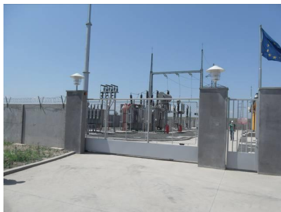
Figura 7: Clădirea de control la situl Parcului Eolian.
