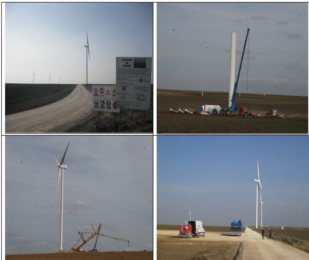
Foto 2 : Aspecte de pe amplasamentul parcului eolian (santier in lucru)
