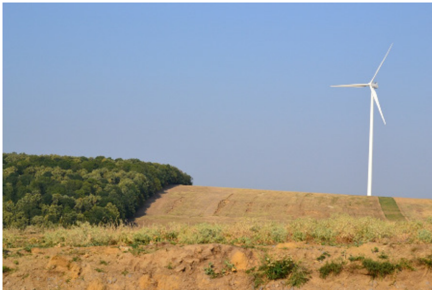
Fig. 5- distanta dintre cea mai apropiata turbine si Padurea Dobrina-Husi
