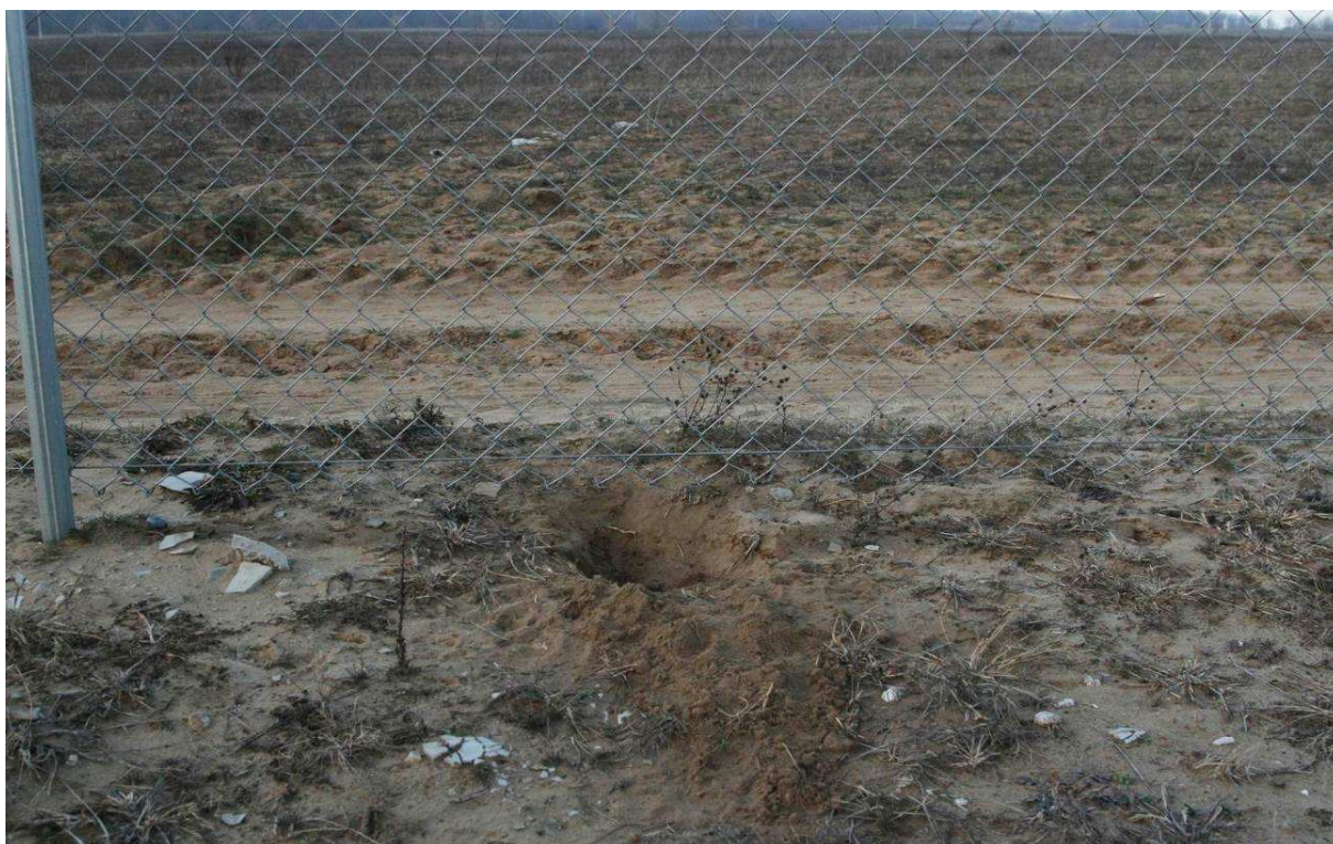
Foto 6 – Săpătură și urme de câini, în zona gardului de protecție al amplasamentului (C.E.F. Burila Mică – decembrie 2013)
