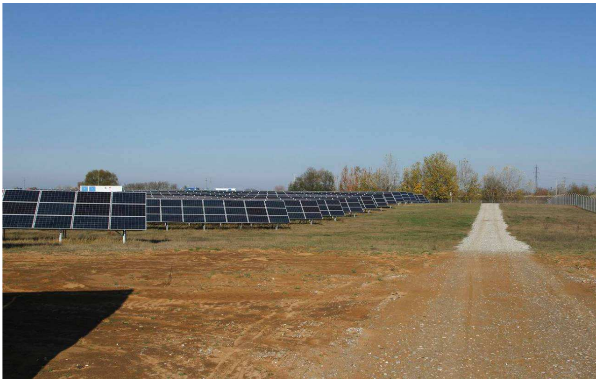
Foto 3 – Aspect din interiorul amplasamentului C.E.F. Burila Mică (noiembrie 2013)
