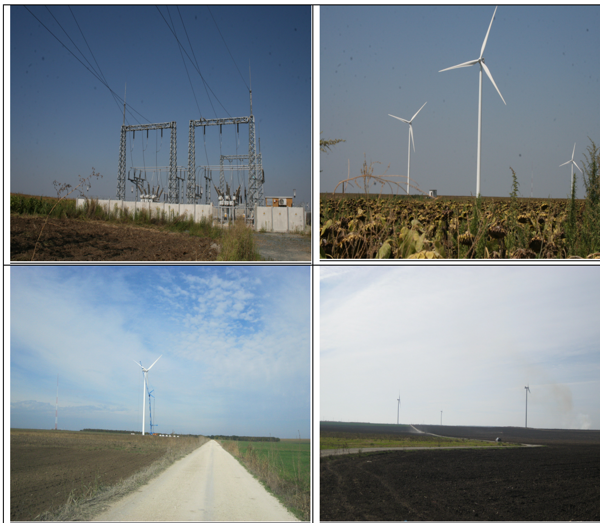
Foto. 1. Aspecte de pe amplasamentul Parcului eolian Ciocârlia-Cobadin, județul Constanța, în perioada monitorizării
