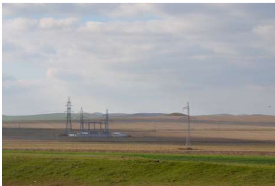
Fig. 7 – statia electrica Zebil
