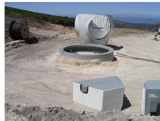
Figura 15 – Aspecto da sapata antes da colocação da torre
