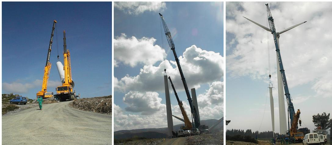
Figura 11 – Montagem de um aerogerador
