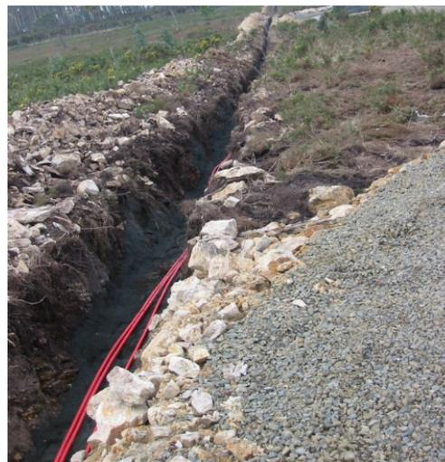
Figura 14 – Aspecto de uma vala para enterramento de cabos eléctricos
