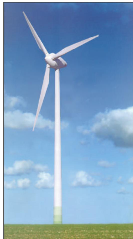
**Figura 4 - Aerogerador ENERCON E66 (1800 quilowatts)**
