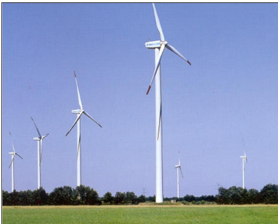
**Figura 3 - Aerogerador ENRON 1.5s (1500 quilowatts)**
