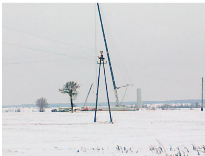
Budowa farmy wiatrowej Pawłowo-Gołańcz
