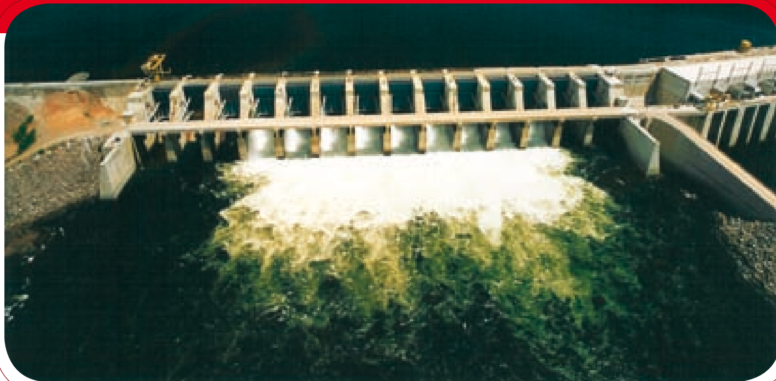
UHE Lajeado - TO
