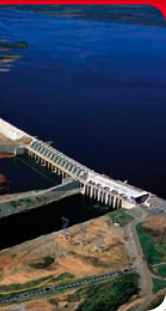
UHE Lajeado - TO
