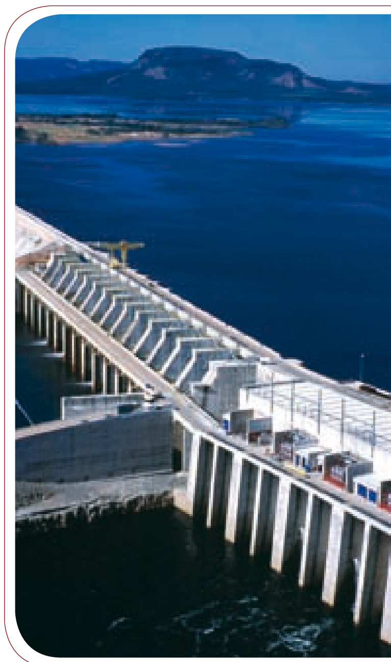
UHE Lajeado - TO
