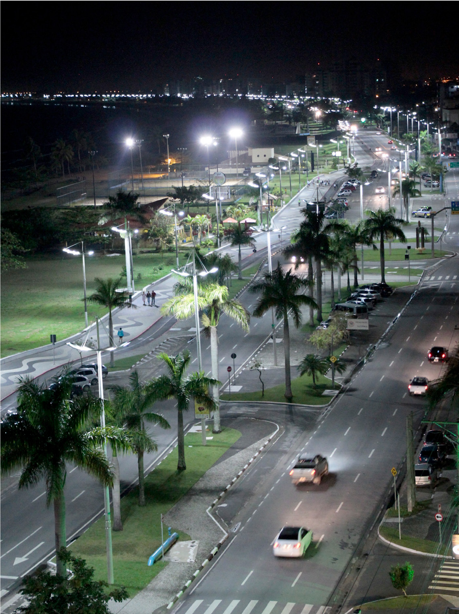
Orla de Caraguatatuba (SP) - área de concessão
