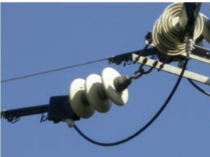
Fotos: 20,21 e 22 - Em cima à esquerda BFV usado nas correcções anti colisão, em cima a direita apoio com medidas de correcção e em baixo pormenor do isolamento no mesmo apoio.
